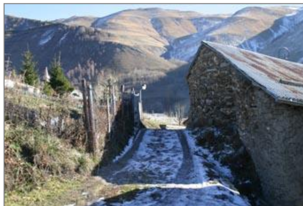
Façades Nord sur un seul niveau
