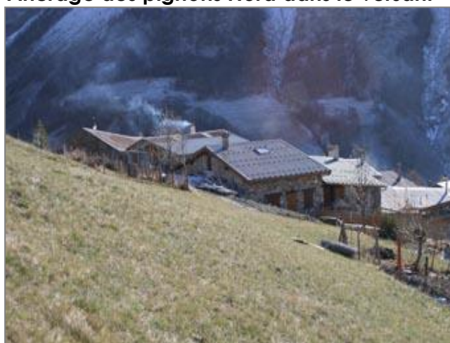
Ancrage des pignons Nord dans le versant
