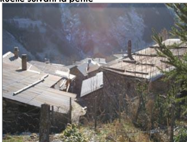
Ruelle suivant la pente
