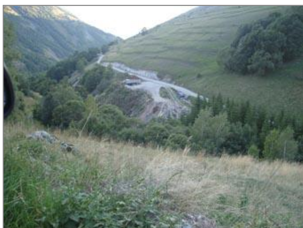
Benne de récupération des encombrants en aval de la route
