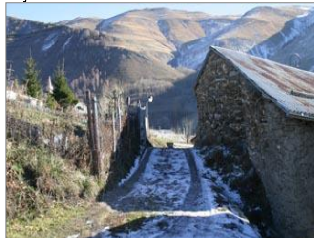
Façades Nord sur un seul niveau
