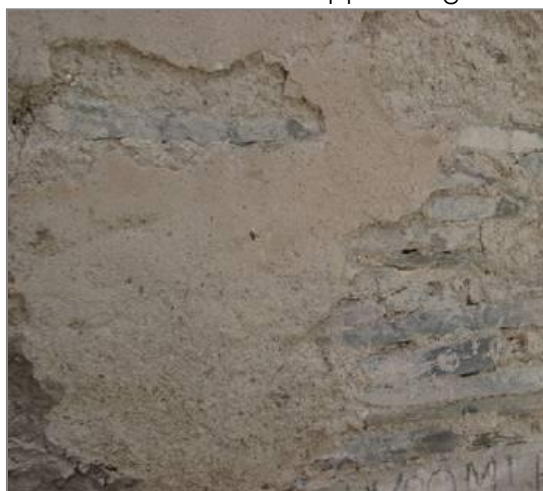
Détail enduit sur appareillage
