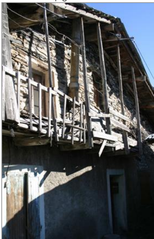
Balcon sur pignon
