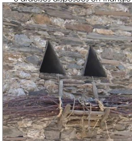
Aérations d'une grange : 3 ardoises disposées en triangle
