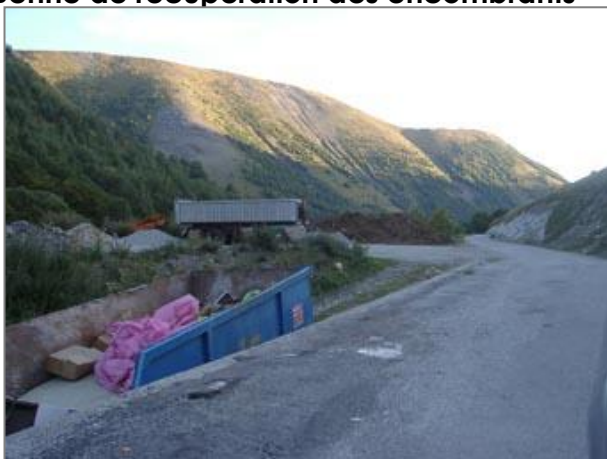
Benne de récupération des encombrants
